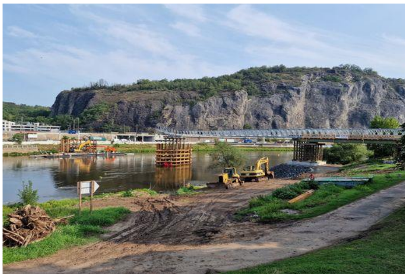
Aktuální snímek z výstavby lávky - úvodní etapy rekonstrukce mostu E. Beneše v Ústí nad Labem; 2024 Ústecký kraj
